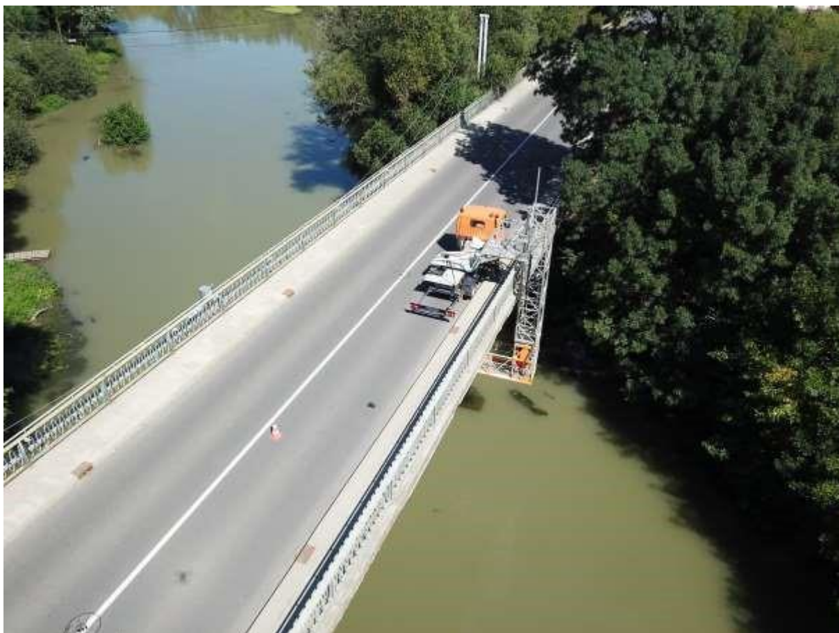
Obr. 6 Využitie mobilnej mostnej plošiny pre odbornú prehliadkovú činnosť na moste M5964 - Tomášov
