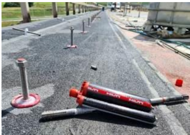
Obr. 2 Kotvenie rímsy na moste 201-00 D1 Prešov, západ – Prešov, juh
