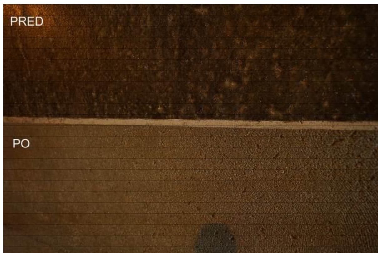
Obr. 3 Detail - porovnanie medzi otryskanou plochou a pôvodným náterom
