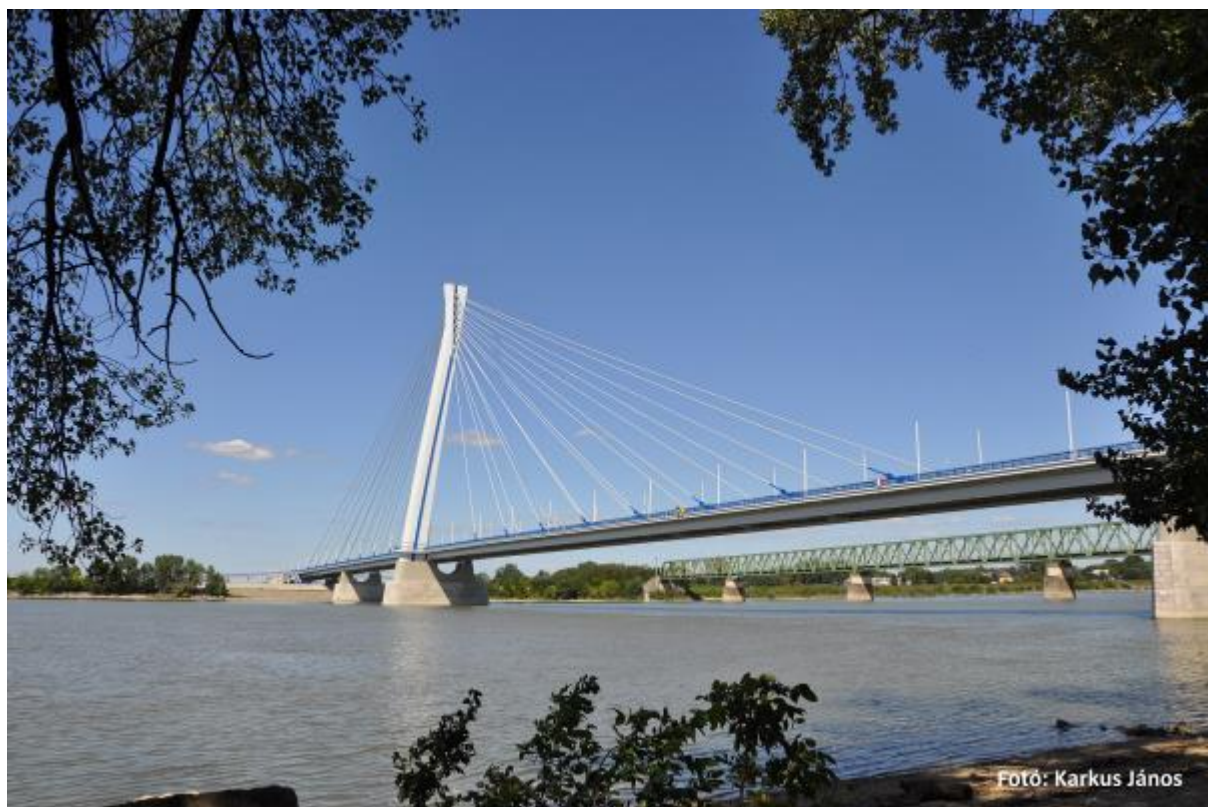
Obr. 1 Pohľad na hotový most z maďarského brehu Dunaja
