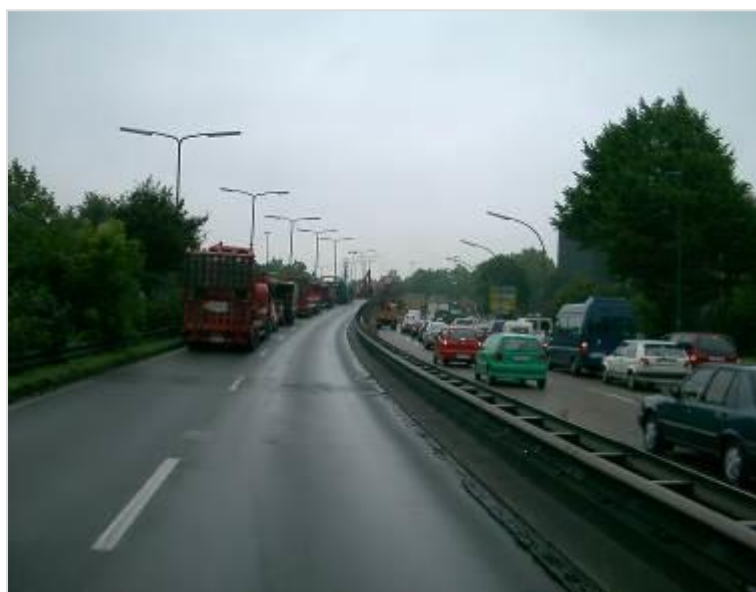
Obr. 1 pohľad na estakádu Nordfriedhof Düsseldorf v čase uzatvorenia stavebného úseku
