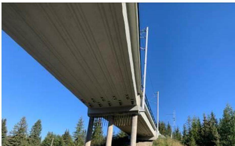
Obr. 4 Pohľad na mostovku zo spodnej strany s finálnym uzatváracím náterom Sikagard®-680 S.
