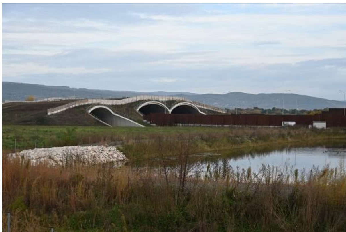
Obr. 4 Celkový pohľad na most 204-01 a 204-02
