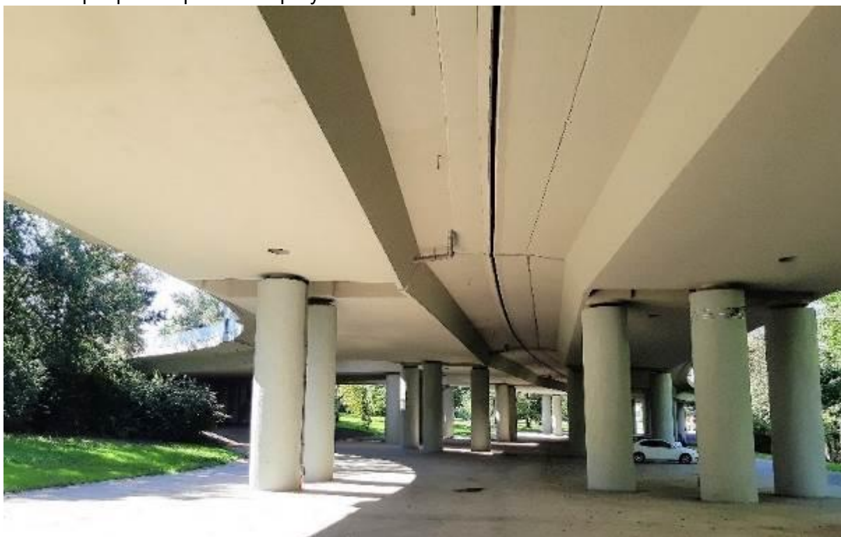
Obr. 2 Celoplošná aplikácia membrány MasterSeal 6100 FX (svetlosivá) na estakádu Bazaly v Ostrave (celkom 20 000 m 2 ) 2 .
