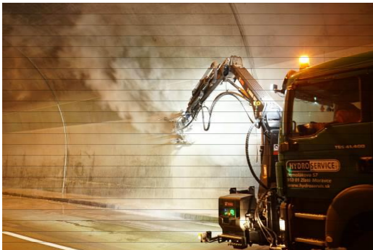
Obr. 2 Pohľad na ostenie tunela počas otryskávania
