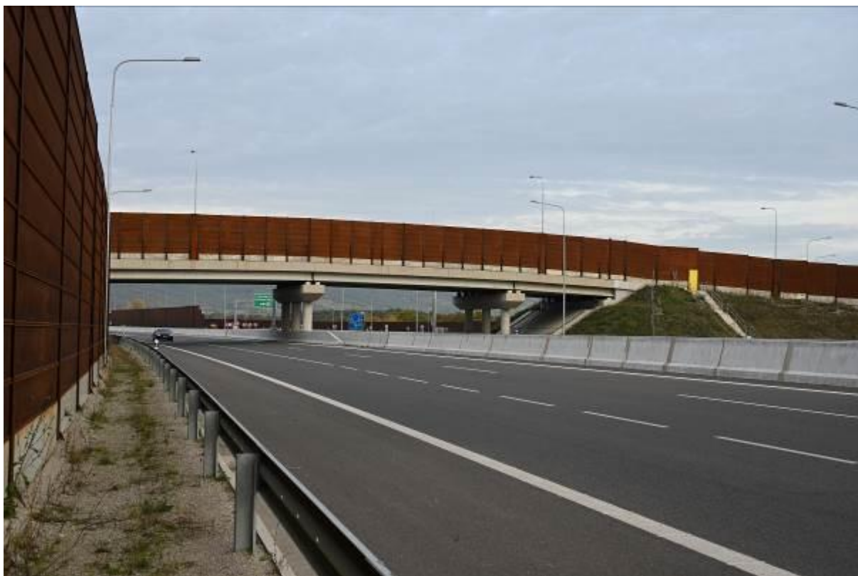
Obr. 3 Celkový pohľad na most 203
