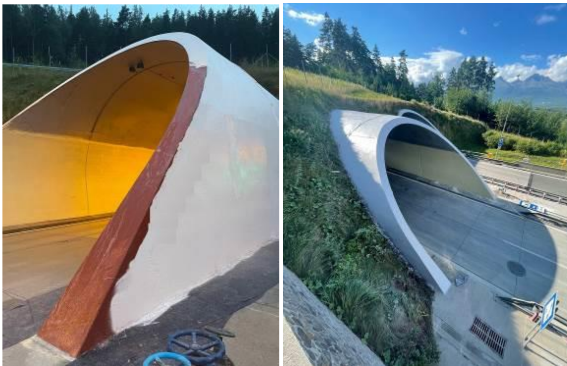
Obr. 8 a 9 Pohľad na úpravu portálov a golierov tunela systémom Sikalastic červená farba – podkladný náter, šedá farba – vrchný náter RAL 7038
