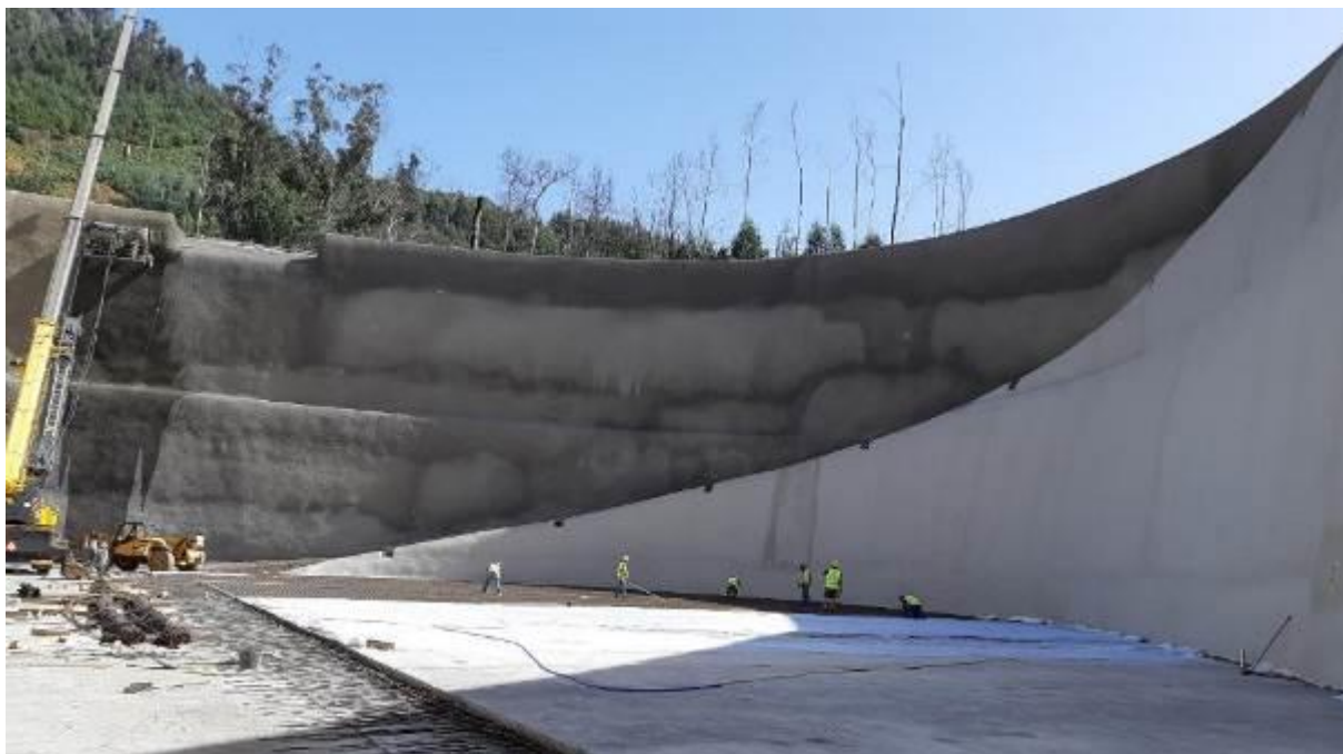
Obr. 3 Aplikácia membrány MasterSeal 6100 FX na steny a dno novej vodnej nádrže s kapacitou 70 000 m 3 na ostrove Madeira.
