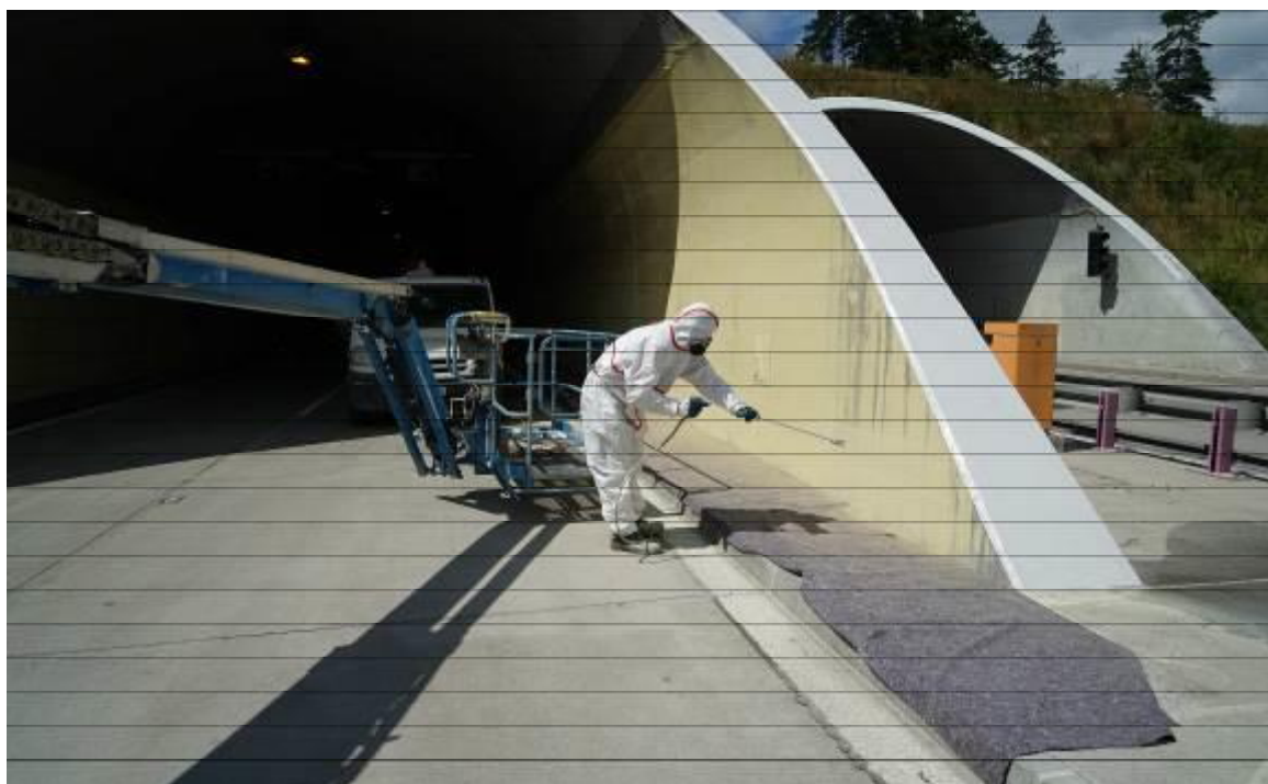
Obr. 6 Aplikácia náteru klasickým spôsobom – airless nástrekom
