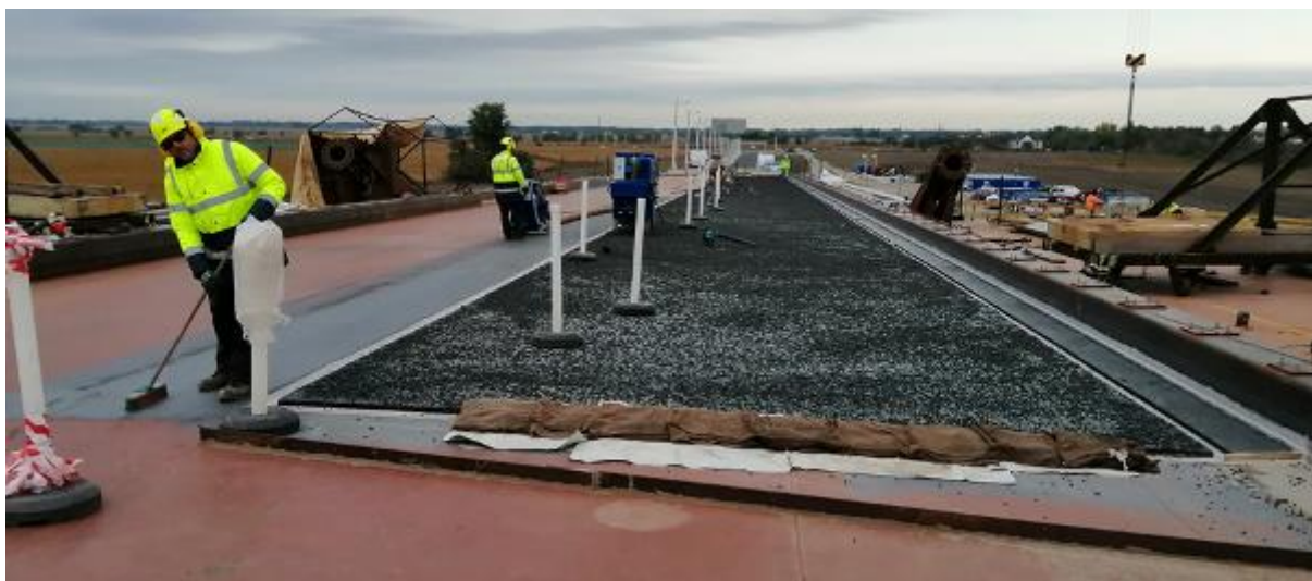
Obr. 5 Realizácia hydroizolácie na moste
