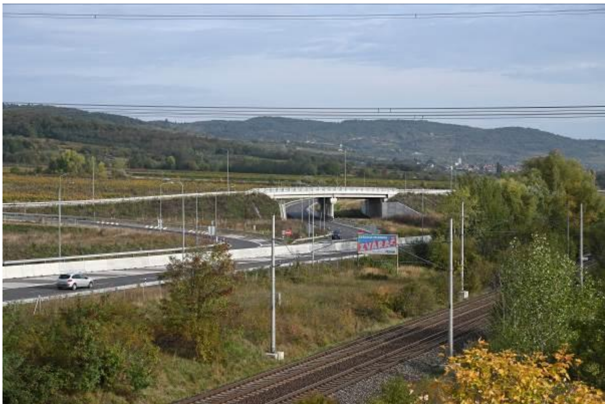
Obr. 6 Celkový pohľad na most 208
