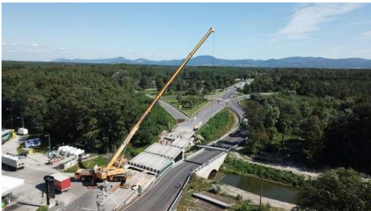
Obr. 3 Rekonštrukcia nosnej konštrukcie mosta M5538 v Malackách s odklonením dopravy na dočasnú komunikáciu v blízkosti mosta.
