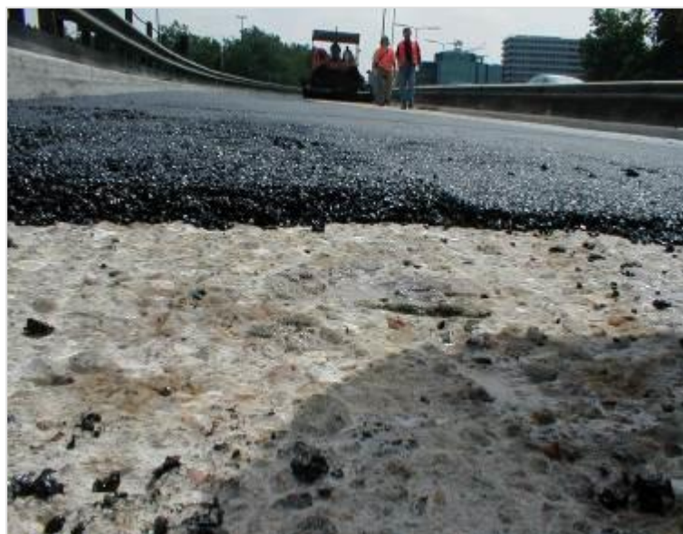
Obr. 2 Položená kostra asphaltovej zmesi s veľkou medzerovitosťou na upravený povrch betónovej nosnej konštrukcie mosta
