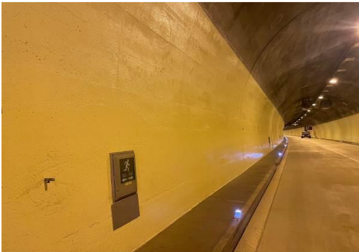
Obr. 7 Detail hotového ochranného epoxidového náteru v odtieni RAL 1014
