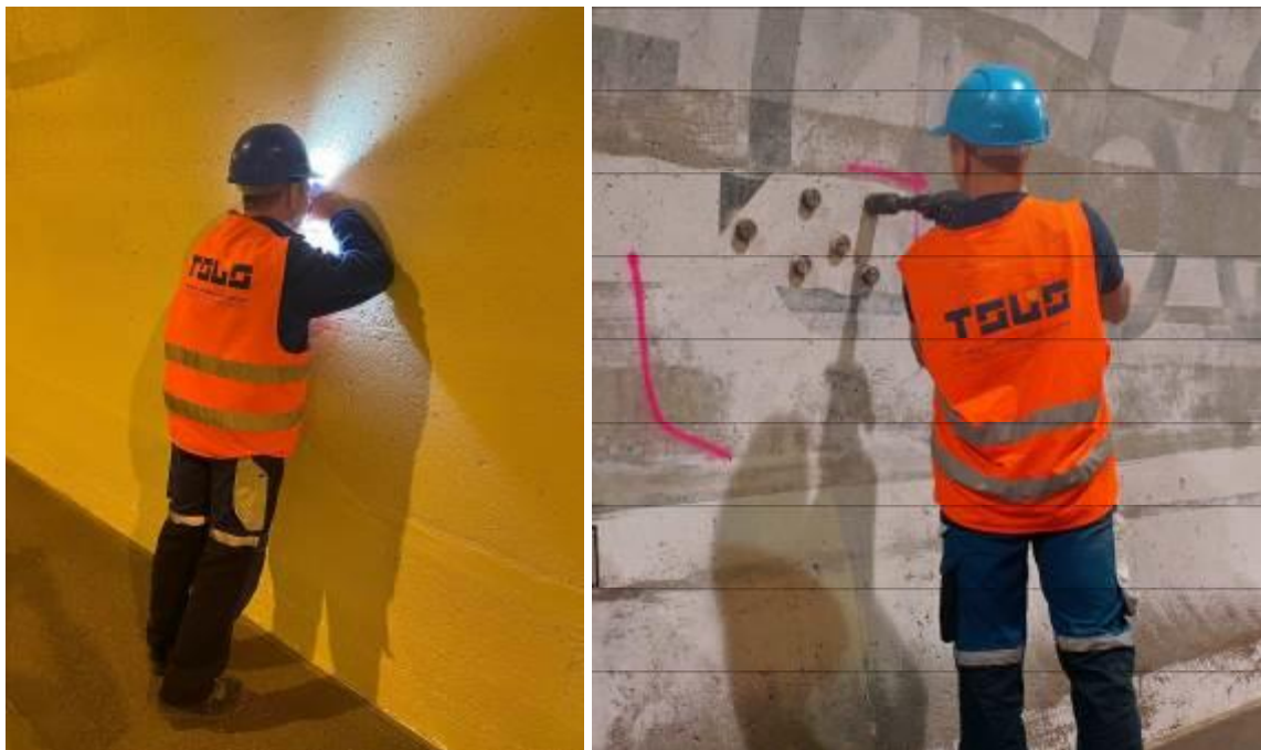
Obr. 11 a 12 Kontrola kvality, vpravo – meranie hrúbky suchej vrstvy metódou klinového rezu, vľavo meranie prídržnosti podkladu odtrhovou skúškou
