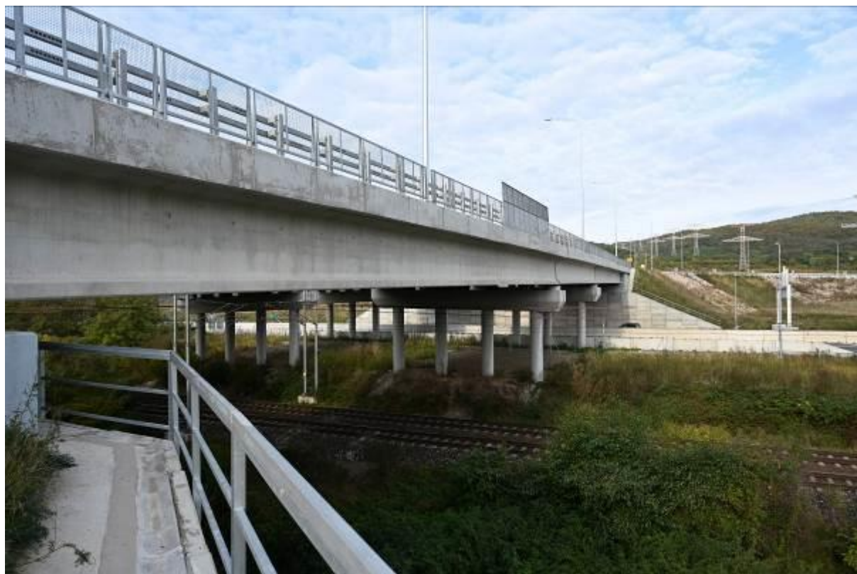
Obr. 5 Celkový pohľad na most 207
