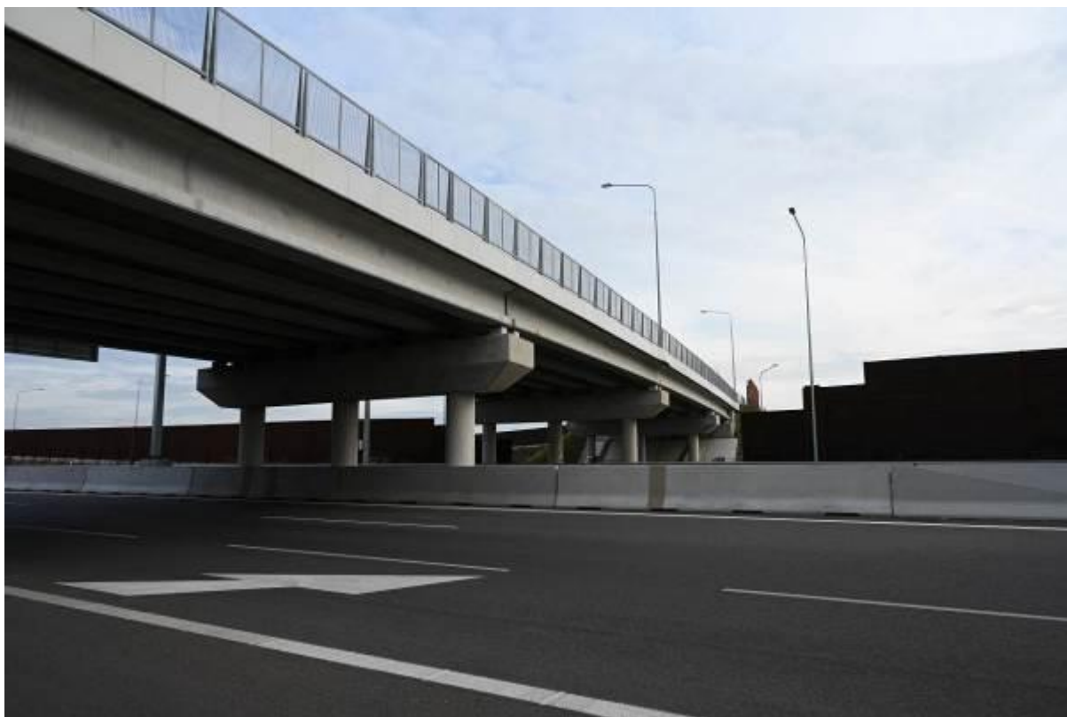
Obr. 2 Celkový pohľad na most 202
