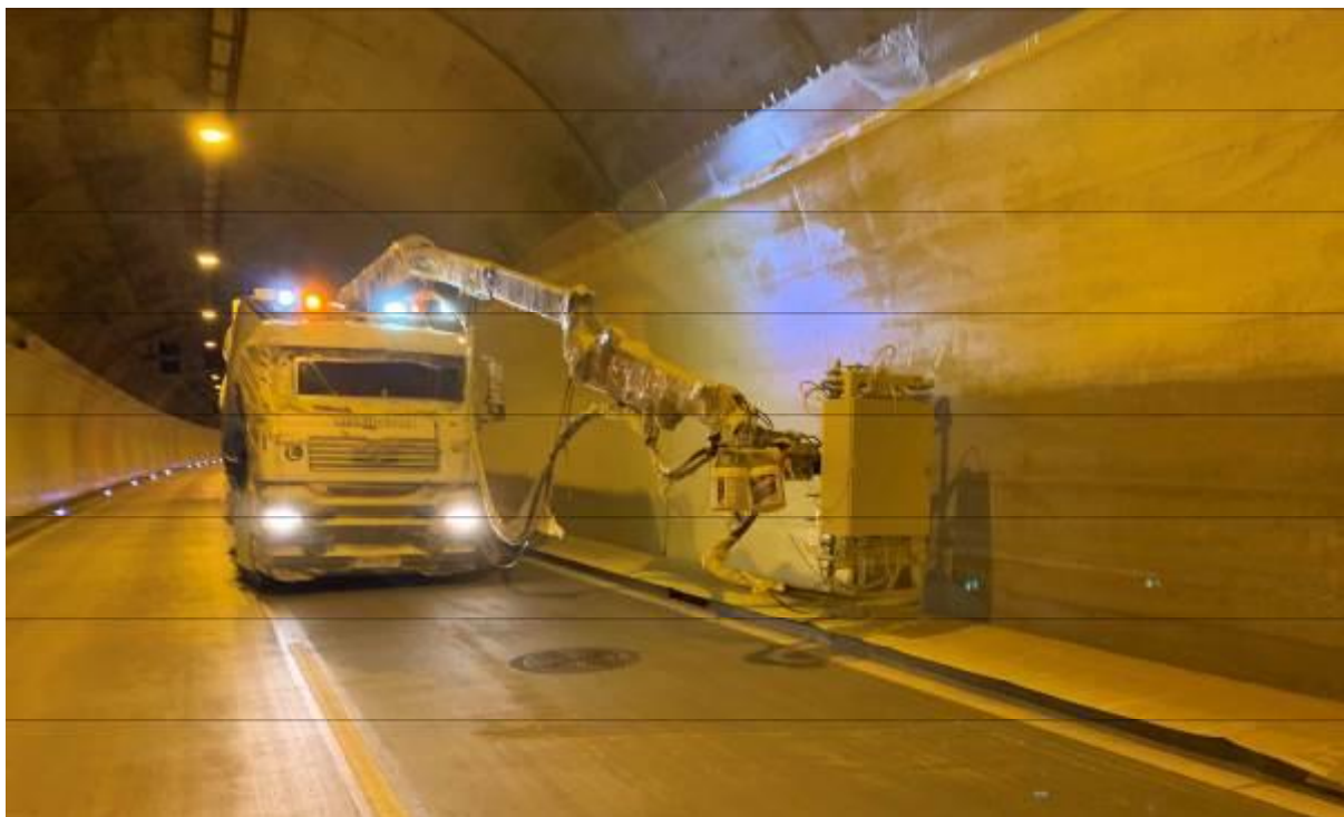
Obr. 5 Aplikácia náteru automatizovaným spôsobom
