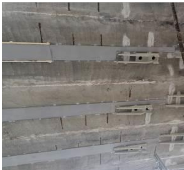
Obr. 1 Pohľad na spodnú stranu mostovky – pripravený podklad pre lepenie lamiel a osadené oceleové deviátory
