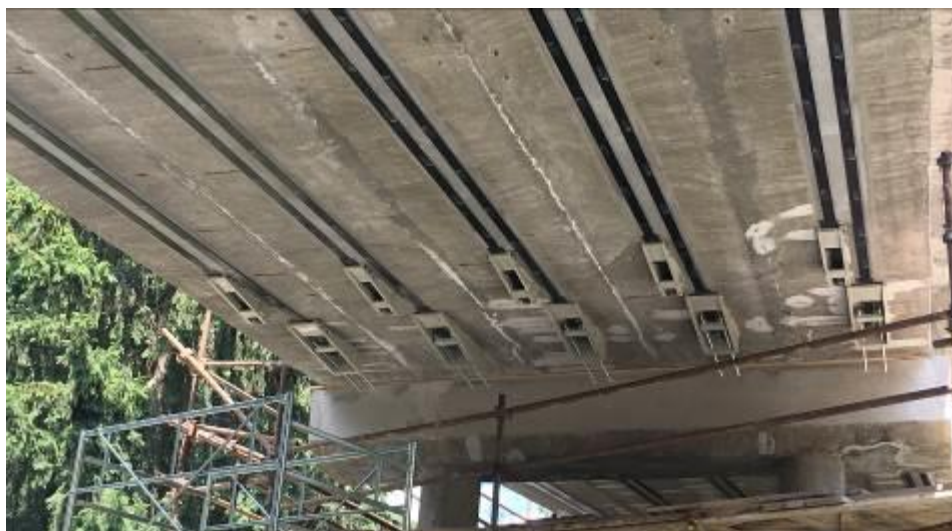
Obr. 3 Predopnuté uhlíkové lamely Sika® CarboDur® S626.
