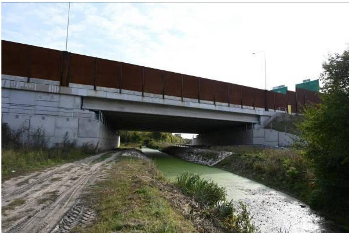
Obr. 1 Celkový pohľad na most 201
