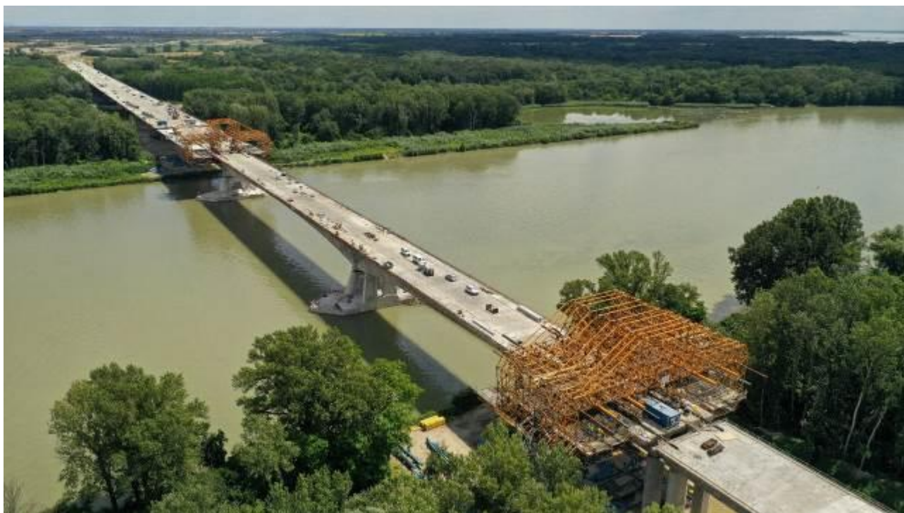
Obr. 3 Dokončené komorové jadro NK mosta cez Dunaj a betonáž krajných konzol v 2. fáze
