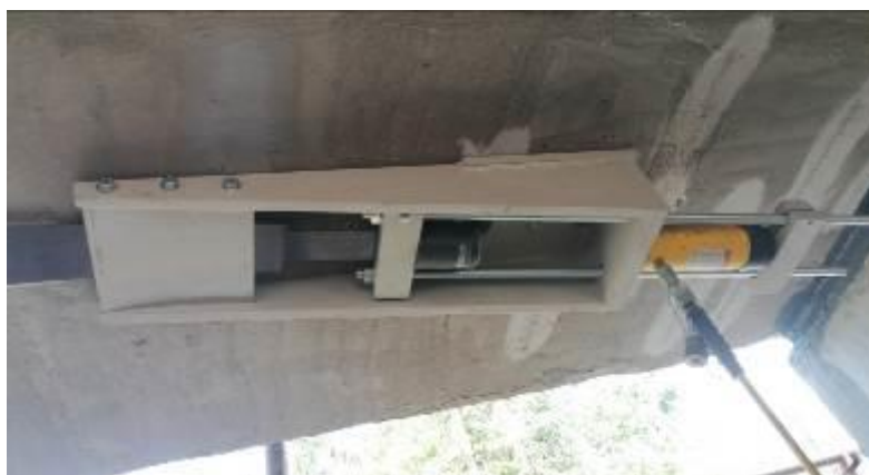
Obr. 2 Oceleový deviátor, aktívna kotva s hydraulickým zariadením – proces predpínania lamiel
