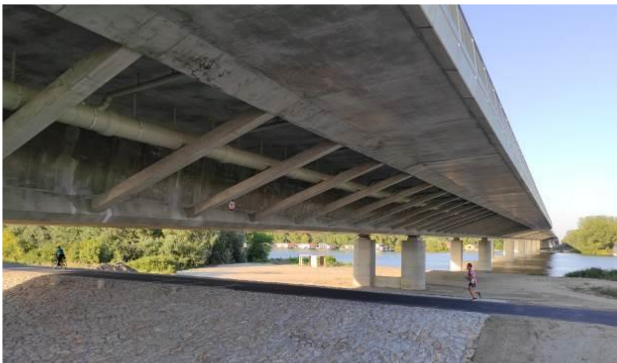
Obr. 6 Pohľad na nosnú konštrukciu s odvodňovacím potrubím
