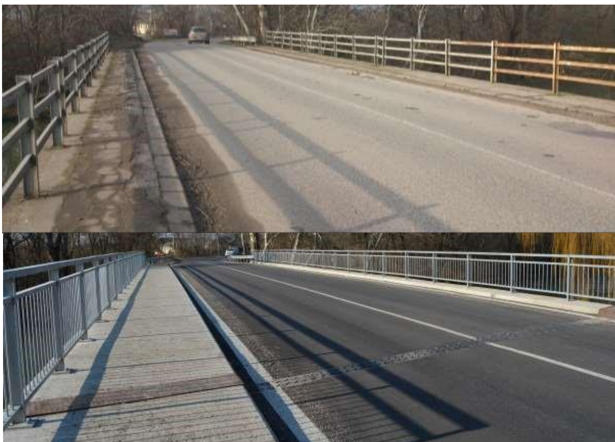
Obr. 5 Zmena šírkového usporiadania pred a po rekonštrukcii mosta M9556 - Malinovo - Zálesie
