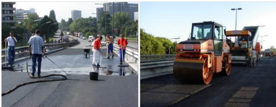
Obr. 3 Zapracovanie tekutej epoxidovej živice do ešte teplého skeletu asfaltovej zmesi. Pokládka asfaltovej zmesi krytu vozovky technológiou „horúce na teplé“
